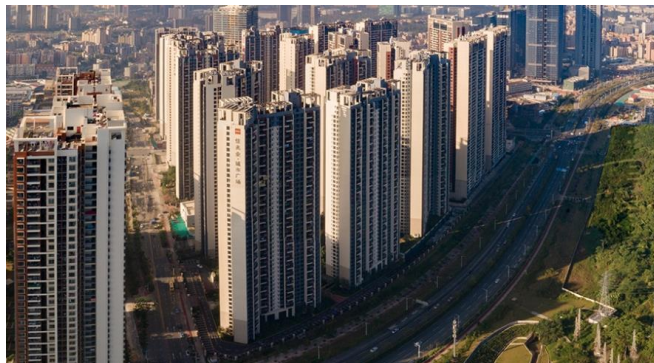
图 改造后的深圳佳兆业城市广场
