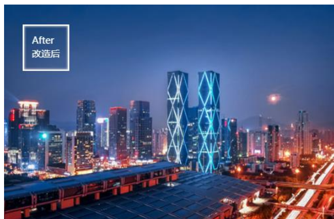
图 改造后的卓越深圳世纪中心
